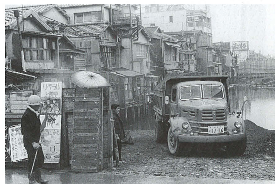
新京橋埋め立て 清岡義道
