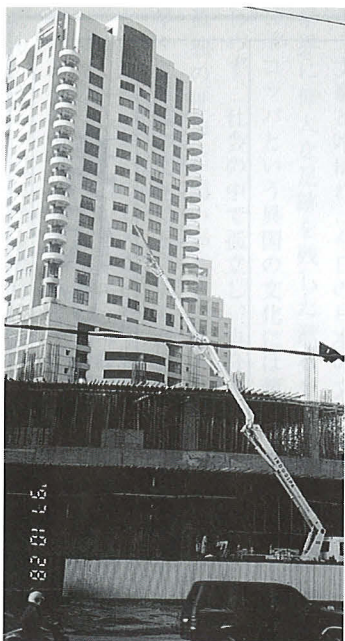
▲建築中のビル
