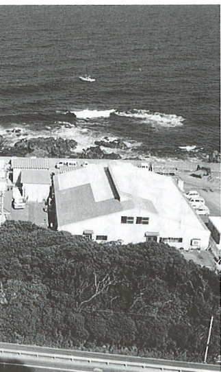
高知県海洋深層水研究所の施設全景
