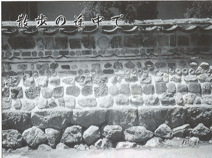
いつ頃築造された土塙だろうか。焼台や土柱(ツク)などの窯道具と、窯壁に使われていた耐火レンガが、横並びに丁寧に埋め込まれている。その隙間は白漆喰で、これまた丁寧に塗り込められている。落ちついた色合いが美しい。廃窯材の再利用といってしまうは簡単だが、施主の窯に対する愛着が偲ばれる。能茶山の麓の一角。
