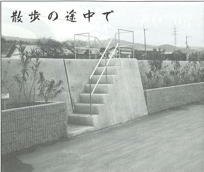
紅水川の中・下流は、垂直に近いコンクリートで囲まれている。水辺というにはやや殺風景になっており、ひと工夫欲しいところ。その試みひとつと思われるが、昇降口の両サイドに植樹帯が設けられていた。
