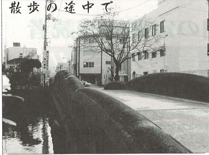
「山田橋」。高知市内に現存する一番古い永久橋で、大正8年の架橋。車の通行量が多く、隣に歩道橋が新設されている。南岸の袂にある桐樹の木が、わずかに昔の風情をとどめている。
