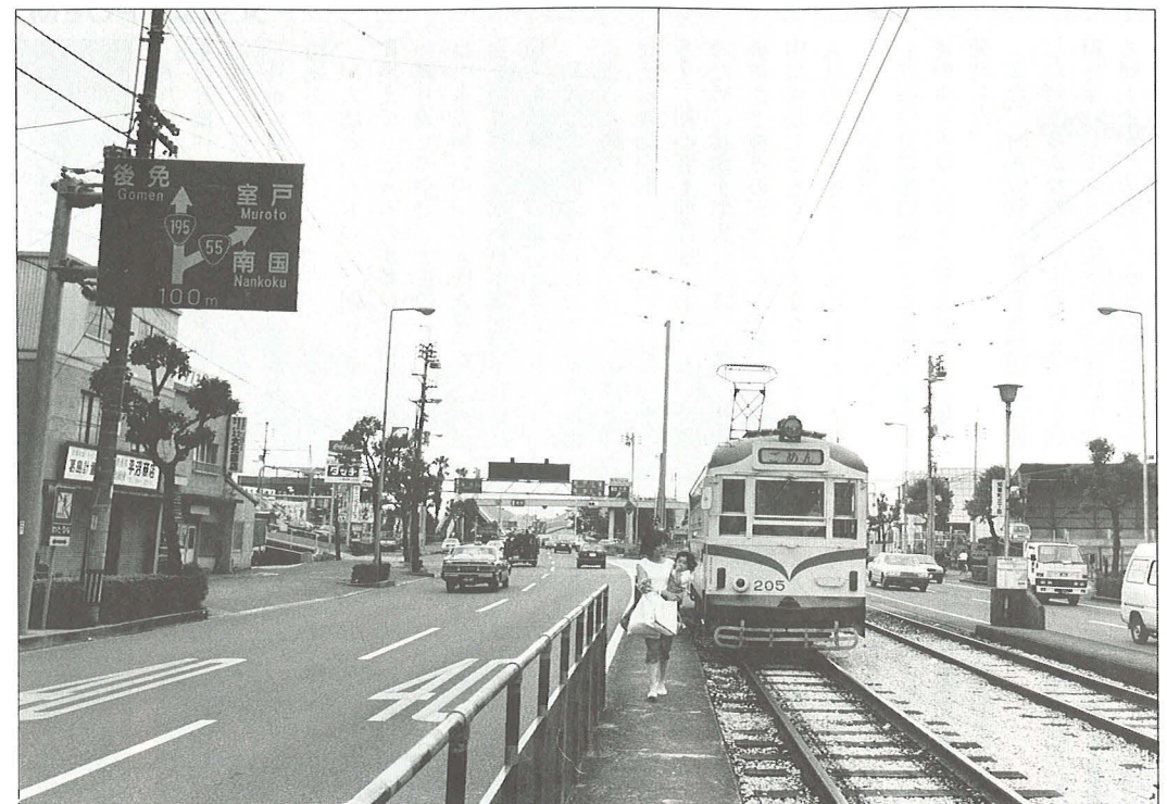
高知の路面電車の歴史は古く、明治37年5月堀詰一五丁目間が開通したのを皮切りに、次々に軌道が延長された。時代は移り、自動車時代になった今も市民の足として活躍している。
