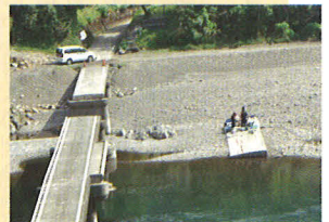
第26回「記録写真部門」特選 流れた橋桁 宮村理生
